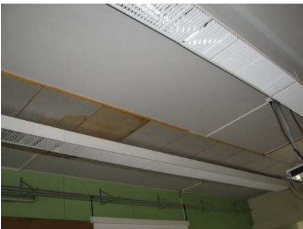
Lämmitysputket on asennettu pintaan.
