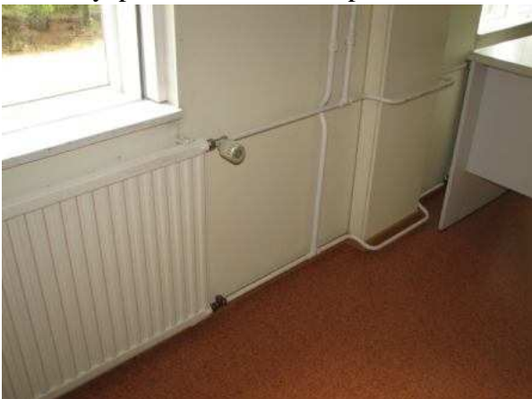
Lämmitysputket on asennettu pintaan.
