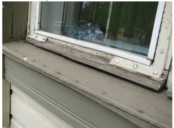
Ikkunoiden puuosat ovat harmaantuneet.
