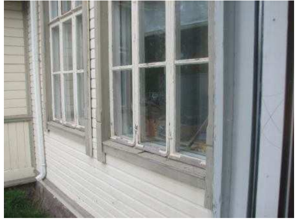
Ikkunoiden puuosat ovat harmaantuneet.
