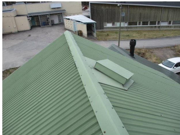
32. Vanhan osan vesikattoa
