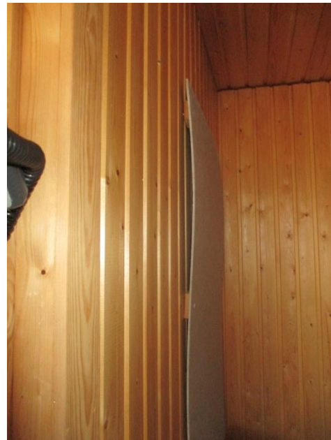
58. Kiukaan suojaseinäke on Minerit- levyä
