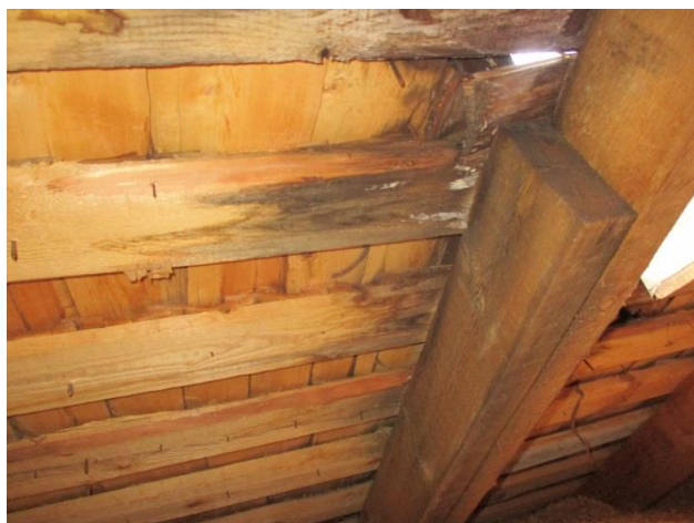
47. ja 48. Yläpohjatilan puuosissa on näkyvillä kosteusvaurioita vanhalla osalla, kattoluukun juuri on vuotanut
