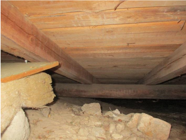
67. ja 68. Alapohjassa on sinne kuulumatonta tavaraa, puurakenteita on maata vasten
