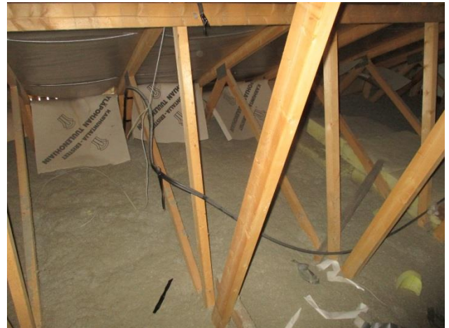
58. Yläpohjan tuulenohjaimet tulee kiinnittää puurimalla yläpaarteisiin
