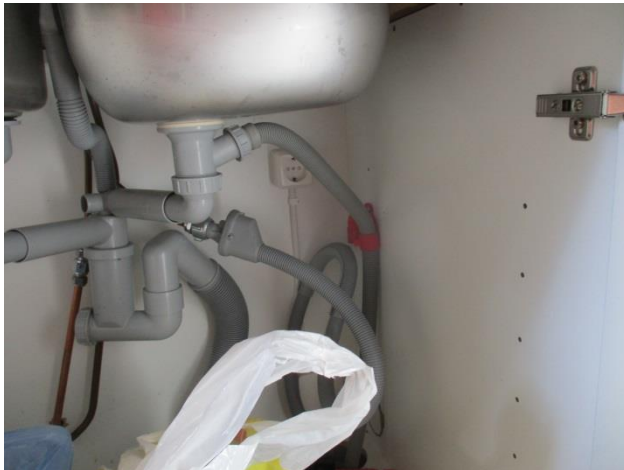
9. Astianpesukoneen poistoputkeen on asennettu poistoputken kaarituki. Tuki tulee kiinnittää mahdollisimman ylös kaapin rakenteisiin.
