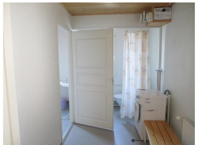
48. Uusimmassa osassa on pesutilat. Pukuhuoneessa pyykkikone
