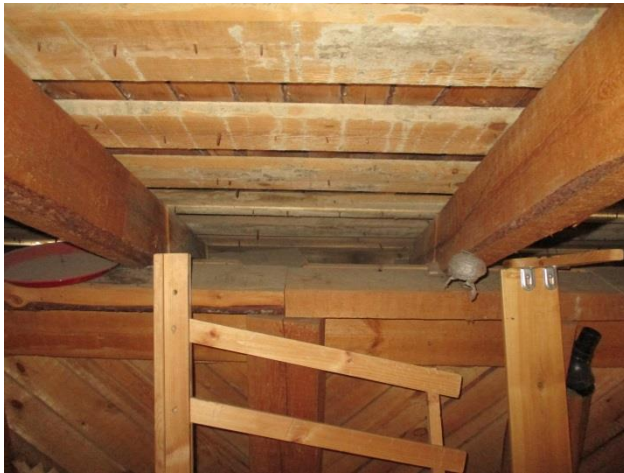
27. ja 28. Räystääs ullakolla
