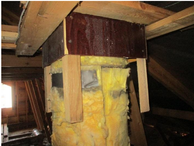
63. ja 64. Putkien eristys laajennusosalla
