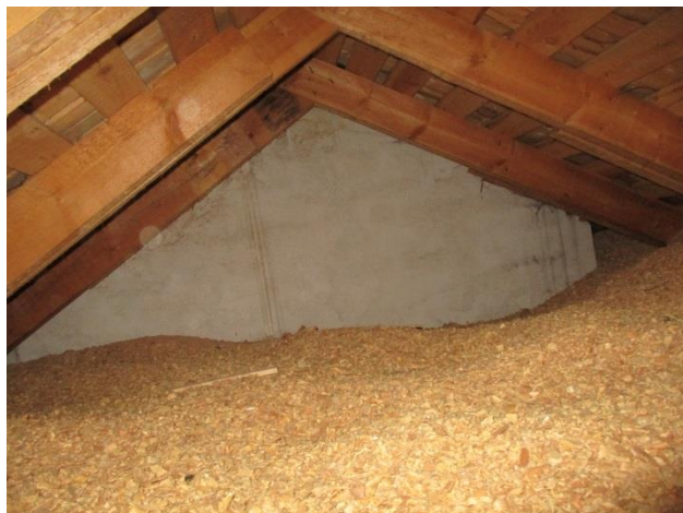
46. Savupiippu yläpohjatilassa
