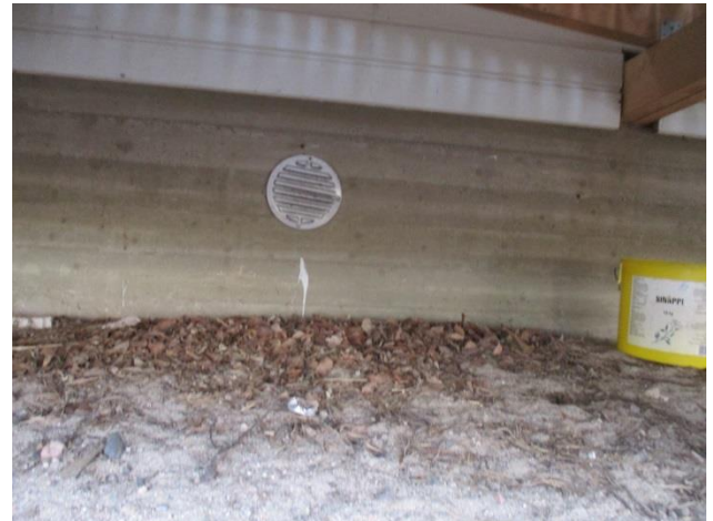
22. Laajennusosan läpi on tehty tuuletusaukko vanhan osan alapohjatilaan
