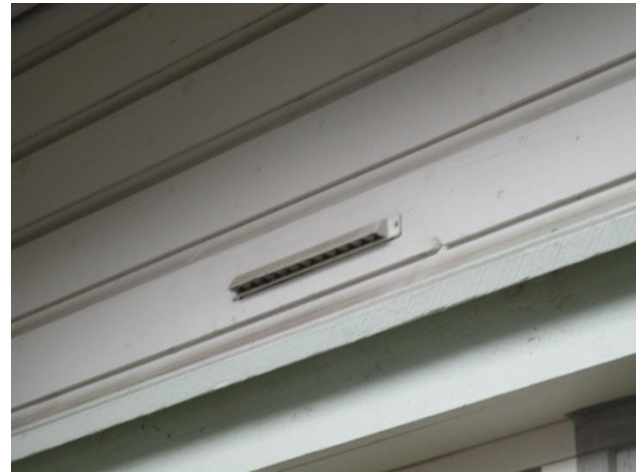
20. Ikkunan päällä on tuloilma-aukko
