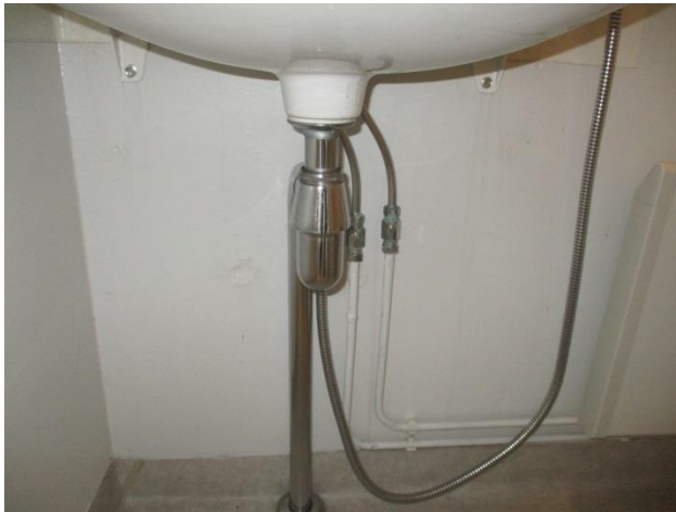
13. Poistovesiputki kannattaa vaihtaa muoviseen
