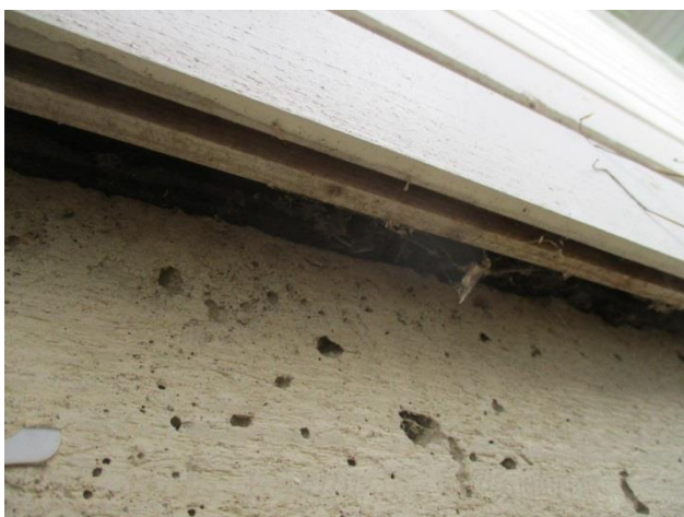
11. Ulkoverhouksen alaosassa on taustatuuletusrako
