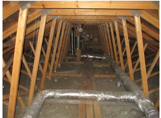
56. Yläpohjatilaa uudella osalla. Putket on eristetty asianmukaisesti ja yläpohjatilassa on kulkusilta
