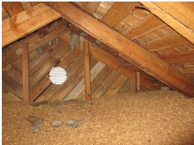
44. Yläpohjatilaa. Päädyssä on yläpohjatilan tuuletussäleikkö vanhimmalla osalla
