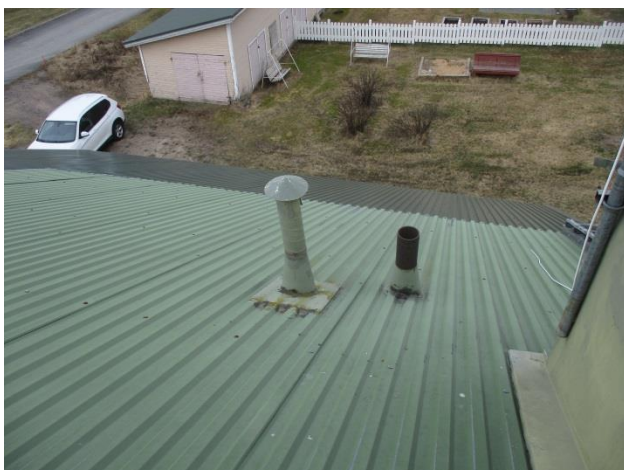
33. Viemärin tuuletusputki ja iv-putki
