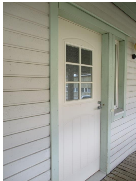
30. Sisäänkäyntiovi uusimmalle puolelle
