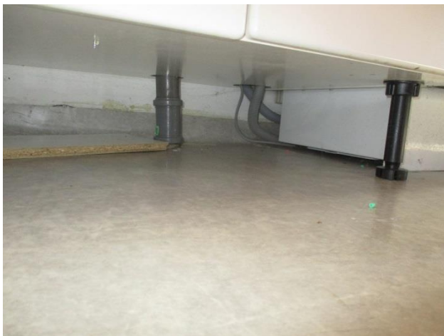
11. Kaapin alaosa. Viemäriputki
