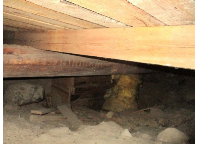
67. ja 68. Alapohjassa on sinne kuulumatonta tavaraa, puurakenteita on maata vasten
