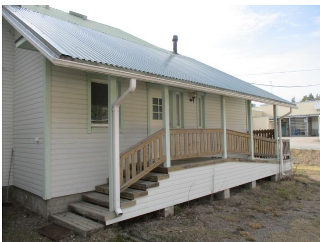
5. Sisäänkäyntiportaat sisäpihalla ja invaluisika uusimpaan osaan
