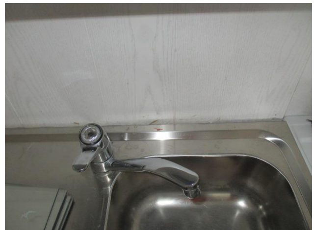
6. Tiskipöydän ja seinän liittymäkohtaan tulee uusia/ asentaa silikonisauma
