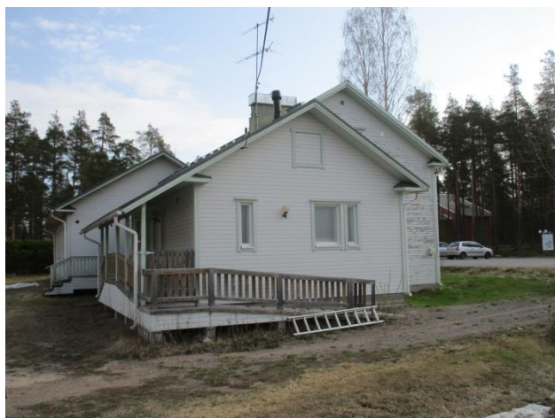
4. Julkisivu, toinen pääty
