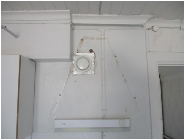
9. Liesituuletin on poistettu keittiöstä
