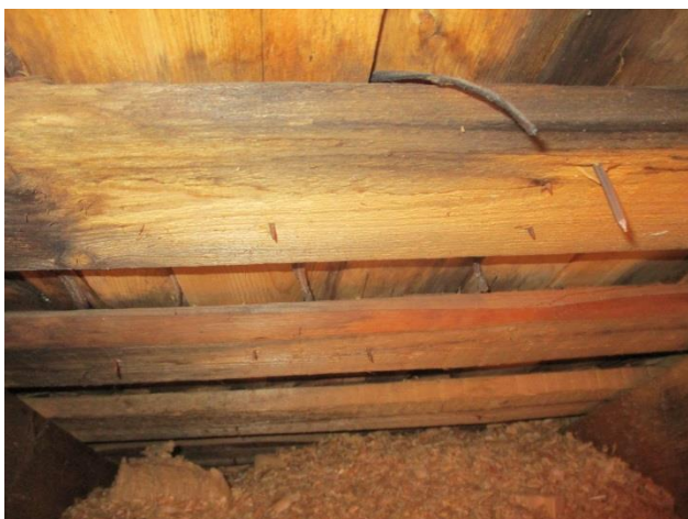
47. ja 48. Yläpohjatilan puuosissa on näkyvillä kosteusvaurioita vanhalla osalla, kattoluukun juuri on vuotanut
