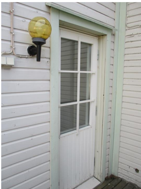
29. Sisäänkäyntiovi uudelle puolelle
