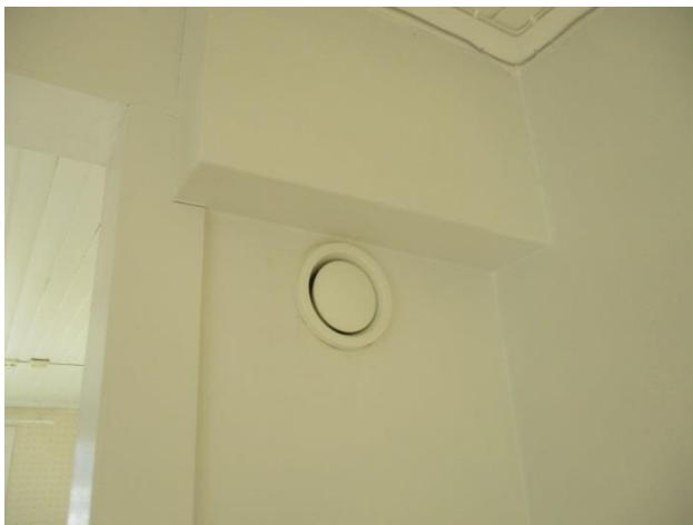
41. Poistoilmaventtiili savupiipussa
