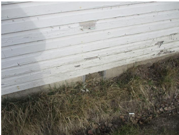
13. Julkisivuverhousmaali irtoaa. Alapohjattilan tuuletusaukko
