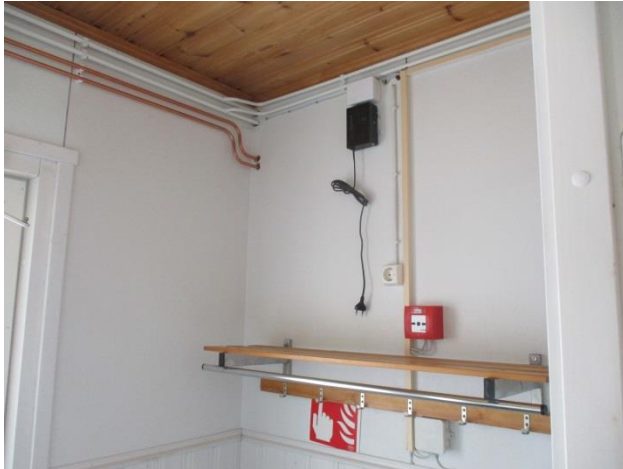
1. Eteinen, käyttövesiputket on uusittu
