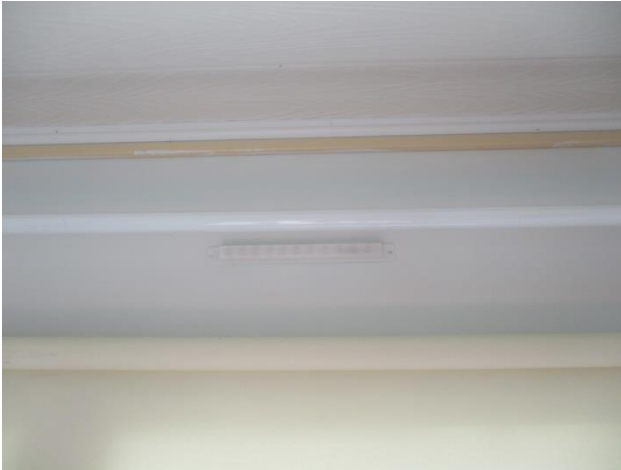
19. Ikkunan yläpuolella on ilmanvaihtoritiä
