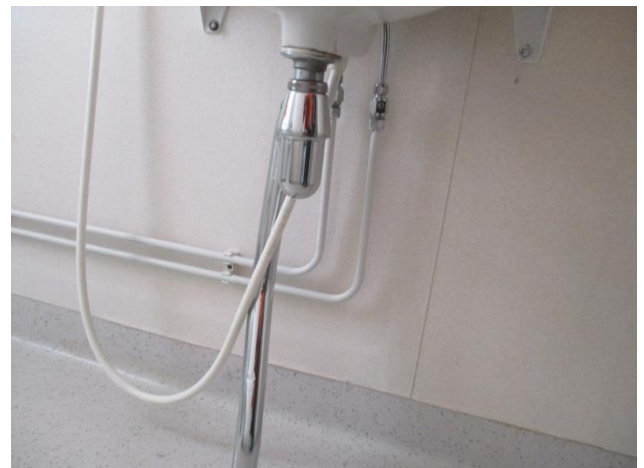
16. Poistovesiputki tulee vaihtaa muoviseen
