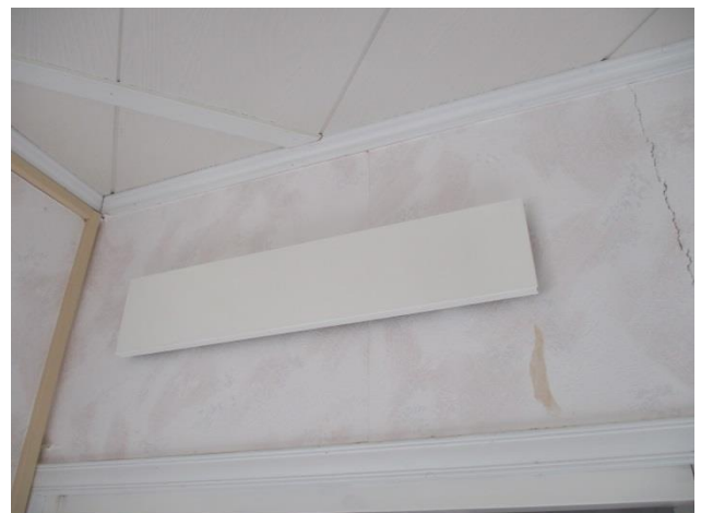
18. Oven yläpuolella on tuloilmaventtiili
