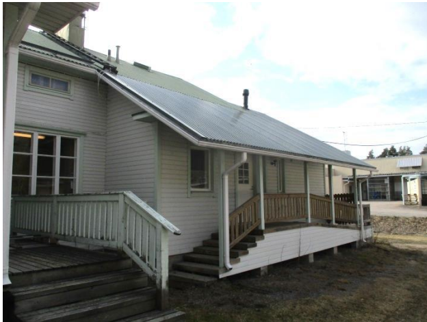
21. Sisäänkäyntiportaat vanhan ja uuden liittymäkohdassa
