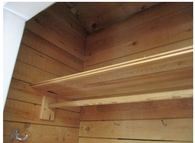
18. Yläkerran komerotilaa, tilassa ei ole ilmanvaihtoa
