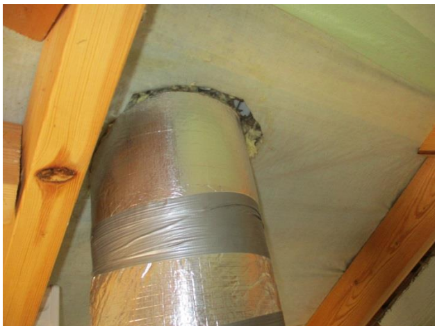
51. Putket on eristetty uudella osalla. vesikaton alle on asennettu aluskate. Aluskate ei ole tiiviisti putkea vasten
