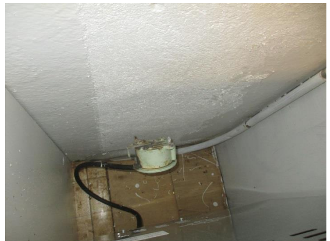
30. Lieden takana oleva pistoke on irronnut, vaara!
