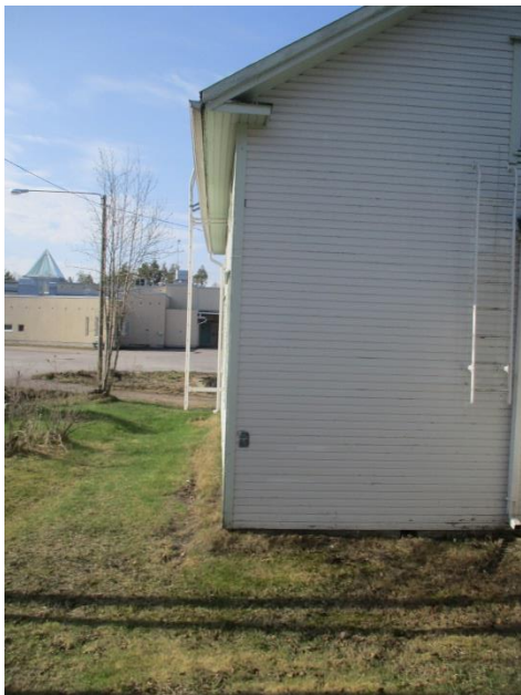
31. Vanhan osan etupuolella maanpinnat on kallistettu hyvin rakennuksesta poispäin
