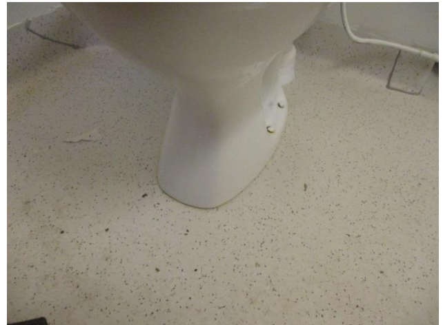
62. Wc- istuimen jalan ympärille tulee asentaa silikonisaumaus
