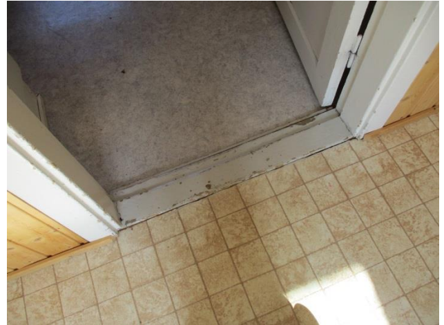
44. Uuden ja vanhan osan liittymäkohdasta kynnyksestä tulee "haju"
