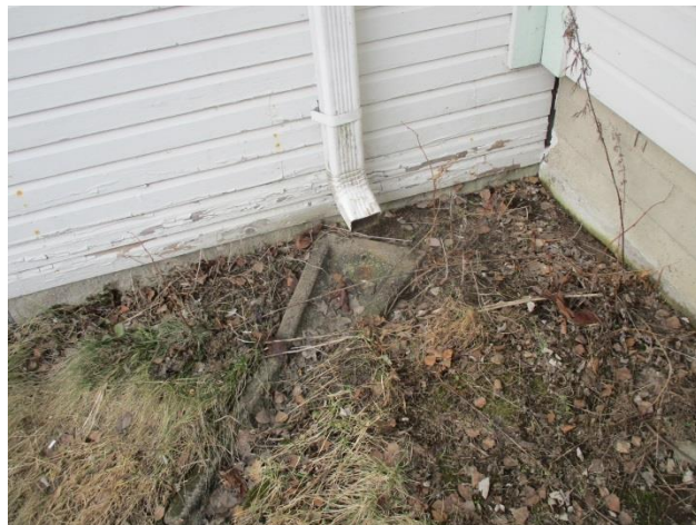
8. Betonikouru alastulon alla. Uuden ja vanhan osan liittymäkohta
