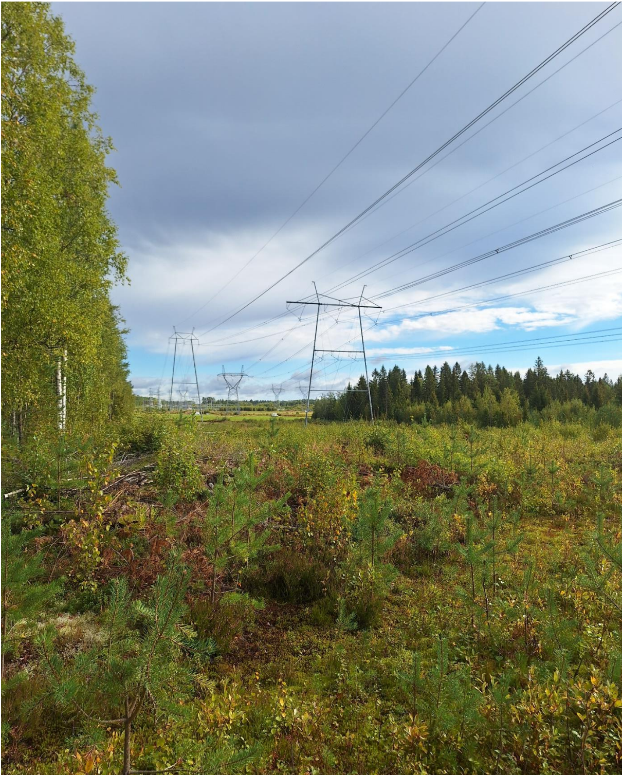
Kuva 17. Voimalinjat erottuvat selvästi maisemassa.
