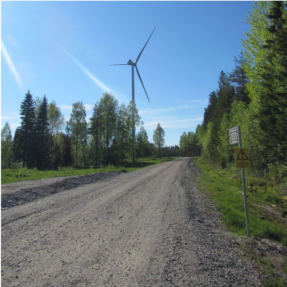
Kuva 2-16. Esimerkki tuulivoimapuiston rakennus- ja huoltotiestä. © AFRY Finland Oy.
