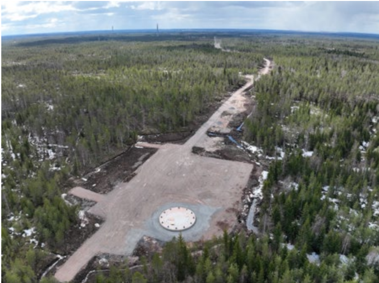
Kuva 2-9. Valmis voimalan nostokenttä ja perustus (kallioankkuriperustus) ennen voimalakomponenttien asennusta. Vasemmassa reunassa näkyy kaksi mursketaskua voimalan lapojen varastoinnille ja tulotien oikeassa reunassa niin sanotut apunosturitaskut päänosturin kokoamista varten. Murskeella katetun alueen ulkopuolinen osa saa kasvittaa rakentamisen jälkeen (tummat alueet). Kuva: Karahkan tuulipuisto (Oulainen) vuodelta 2024.
