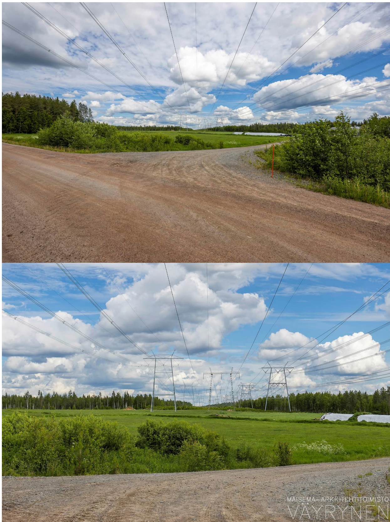
Kuva J. Näkymä Leppiojanperältä kohti voimajohtojen vaihtoehtoja SVE2B. Uusi voimajohto on oikeanpuoleisin. Ylemmän kuvan objektiivi on 16 mm ja alemman 50 mm.
