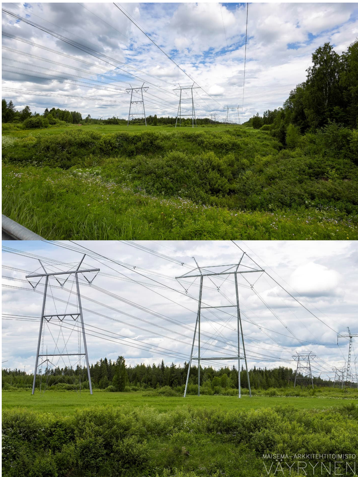
Kuva M. Näkymä Raahentieltä Latvan kylältä kohti tuulivoimapuistoa (VE1) ja voimajohtojen vaihtoehtoja SVE2A ja SVE2B. Uusi voimajohto ja sen pylväs on vasemmanpuoleisin. Ylemmän kuvan objektiivi on 16 mm ja alemman 50 mm.
