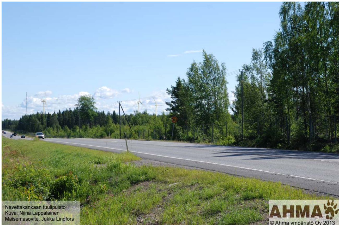
Kuva 32. Kuvasovite valtatieltä, 2,5 km päästä puiston luoteispuolelta
